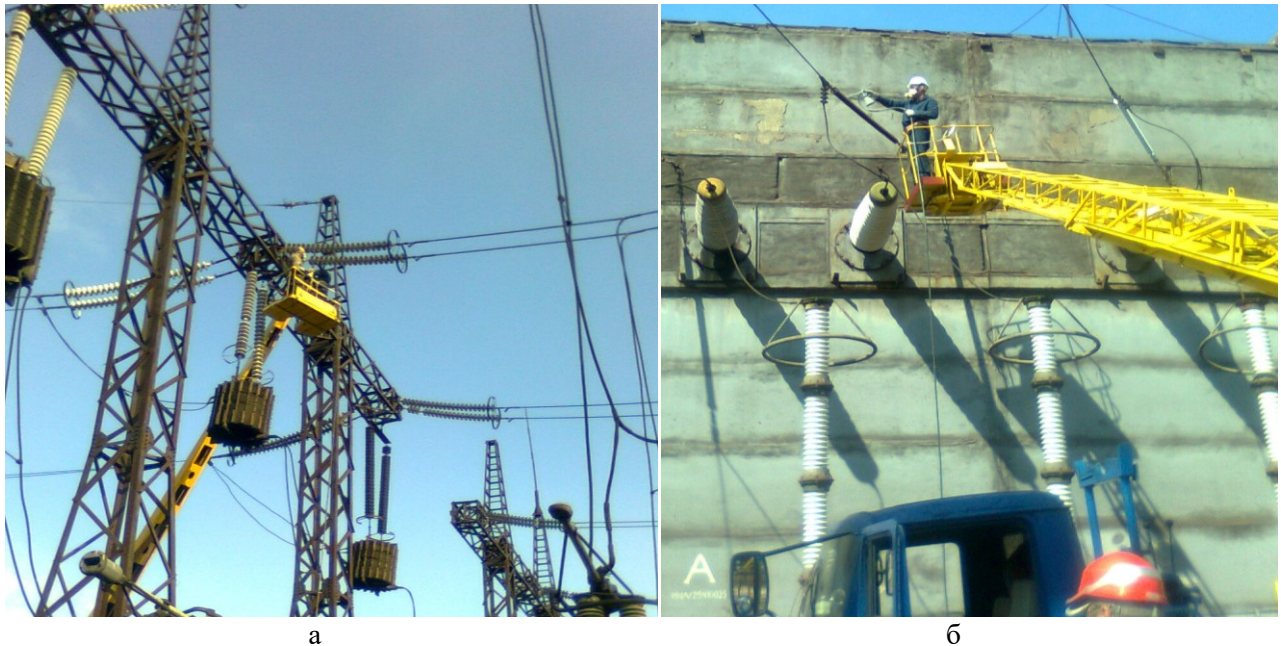
Рис. 7. Нанесення RTV покриття на скляні ізолятори ВРП-330 кВ Курахівської ТЕС (а), полімерні ізолятори ВРП 150 кВ «Запоріжжкокс»: (б).
