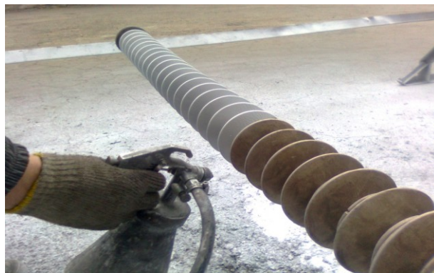
Рис. 8. Нанесення RTV покриття на поверхню демонтованих ізоляторів ЛК 70/220-7 («Азовсталь», 2013 р.)
