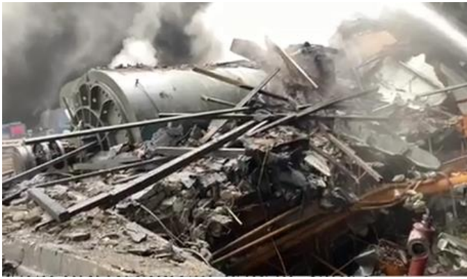
Рисунок 1 – Зруйнований блок Бурштинської ТЕС з турбогенератором ТГВ-200-2УЗ
