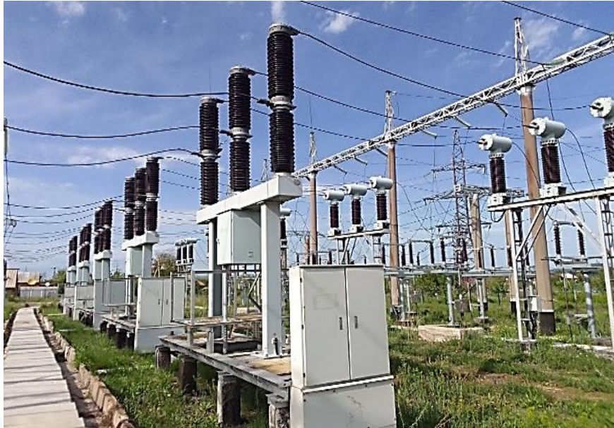
Рисунок 1 – Підстанція 110/35/10 кВ [1]
