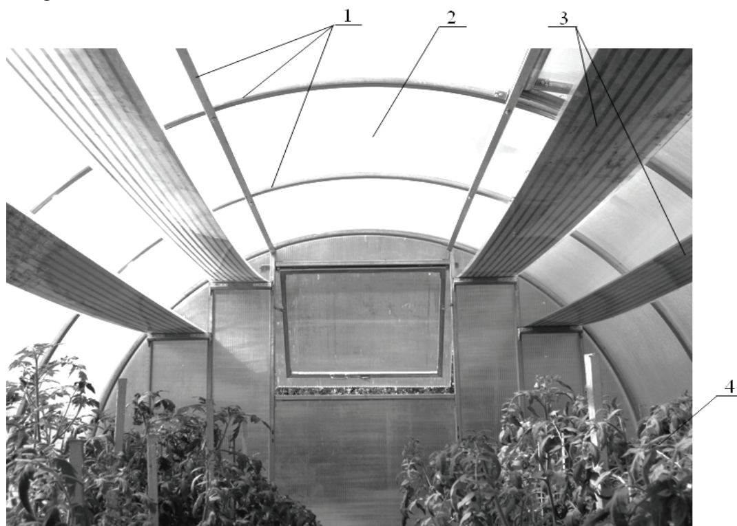
Рис. 3. Теплица, отапливаемая с помощью подвесных инфракрасных карбоновых пленочных электронагревателей: 1 – несущая конструкция покрытия теплицы арочного типа; 2 – поликарбонатное светопрозрачное покрытие теплицы; 3 – подвесные инфракрасные карбоновые пленочные электронагреватели; 4 – выращиваемые растения
