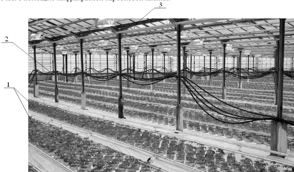
Рис. 2. Теплица с подогревом почвы с помощью инфракрасной карбоновой пленки:
